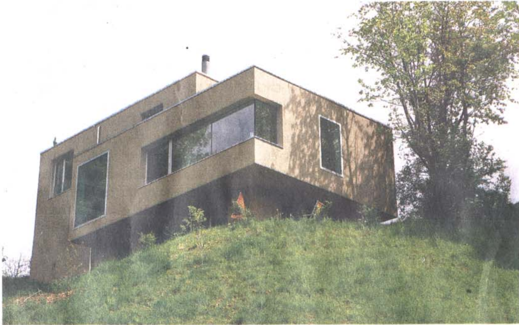
Construite sur un terrain à forte déclivité, la maison de la famille Baertschi offre une vue spectaculaire sur Yverdon, le Jura et Neuchâtel.
