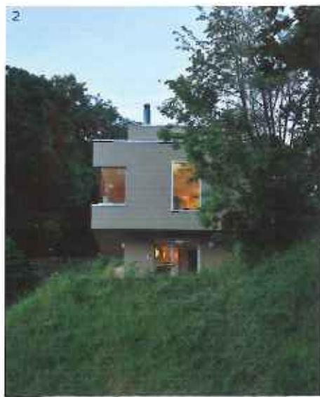
1_Der Durchblick zeigt: Das Haus steht wie eine Tribüne über dem abschüssigen Gelände oberhalb der Schwemmebene. 2_Blick auf die Westseite: Ein alter Baumbestand säumt das halbrichterförmig abfallende Gelände.
